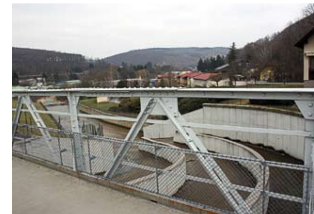
Der Abflusskanal aus dem Wienerwaldsee neben der Staumauer
