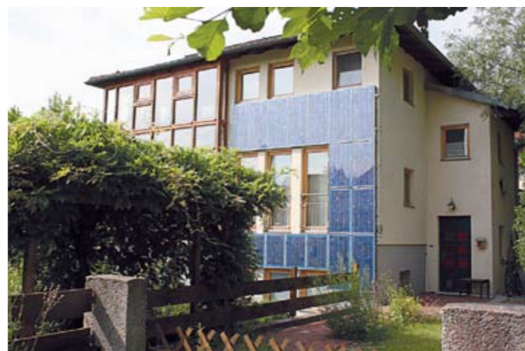
Thermische Solaranlage zur Wassergewinnung – einfach und kostengünstig aufgebaut
