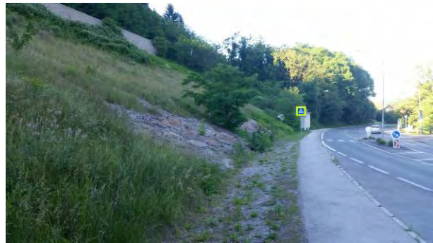
Blick auf Umwidmungsbereich von unten
